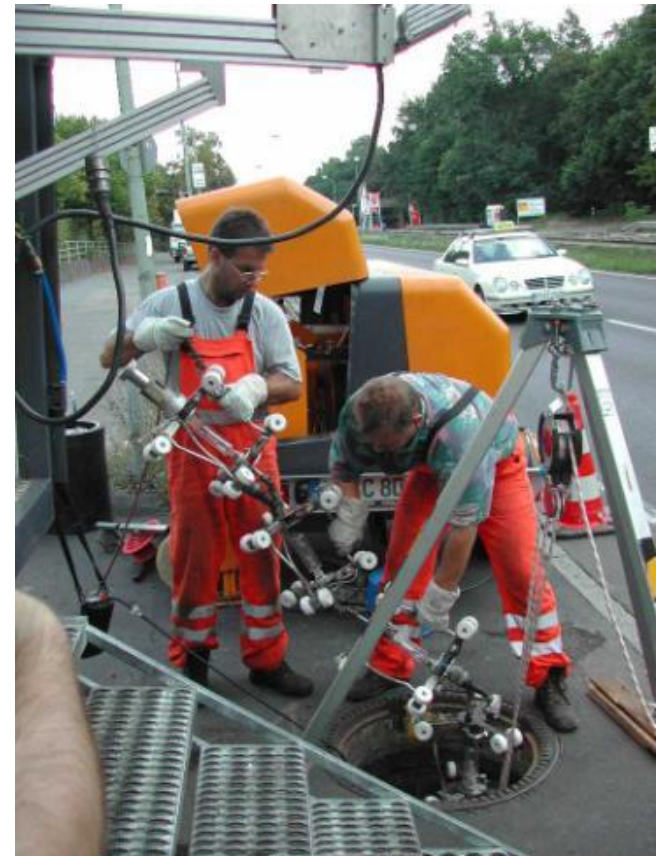
UV lámpafüzér szerelése
