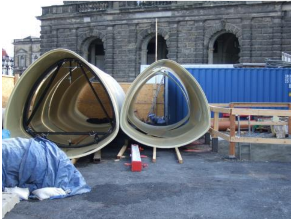
5.7a) ábra Szennyvízcsatorna főgyűjtő GRP bélelése Dresden-ben (2900:2780)
