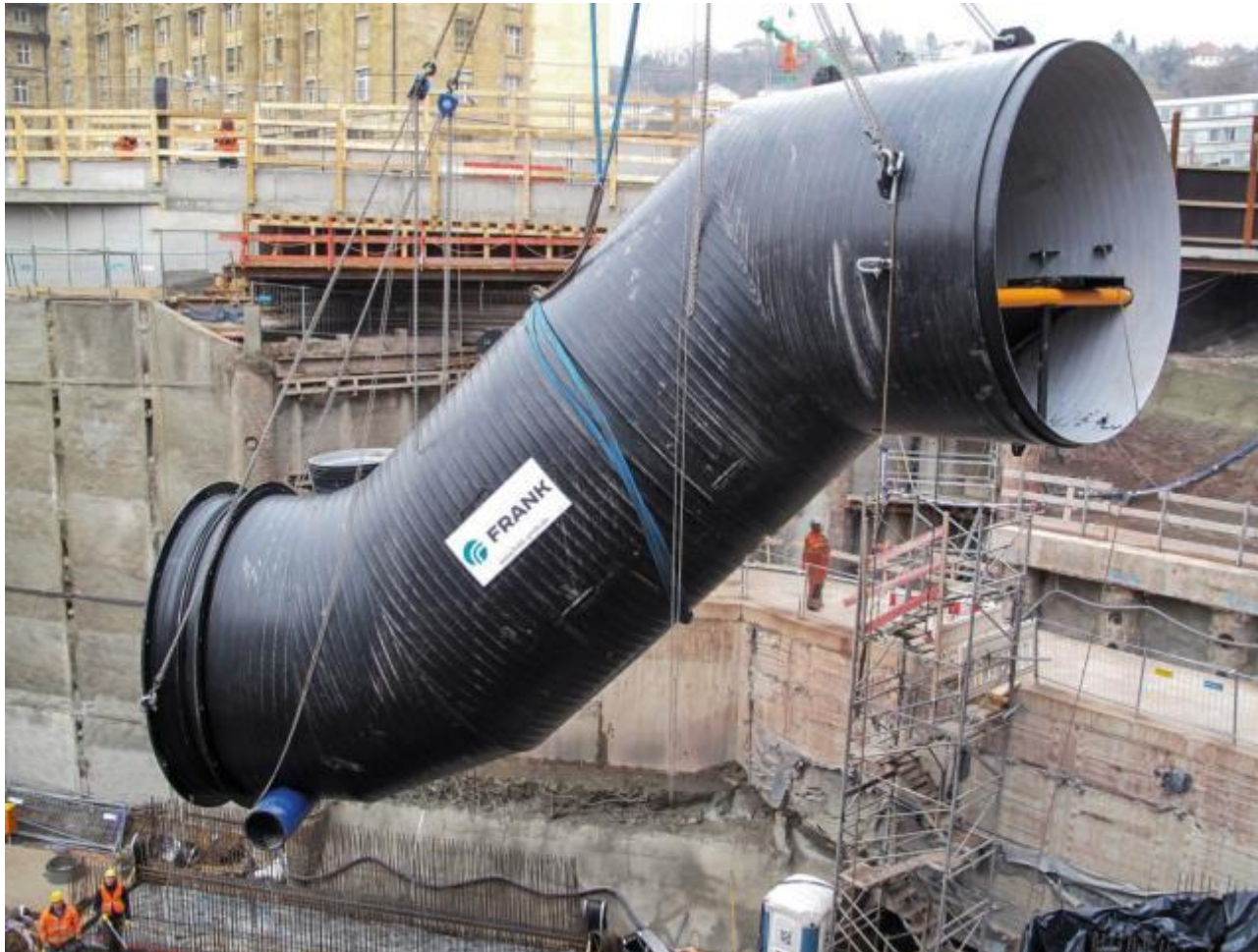
5.3a) ábra Szennyvízvezeték DN 3500, vasúti kereszteződés (Foto: Frank GmbH)
