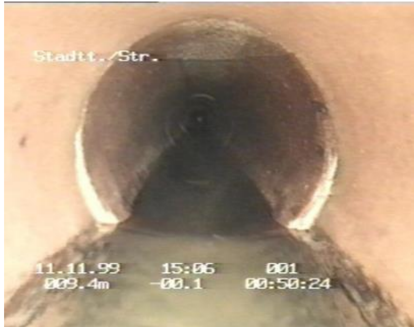
1.7 ábra Függőleges irányú tokelmozdulás
