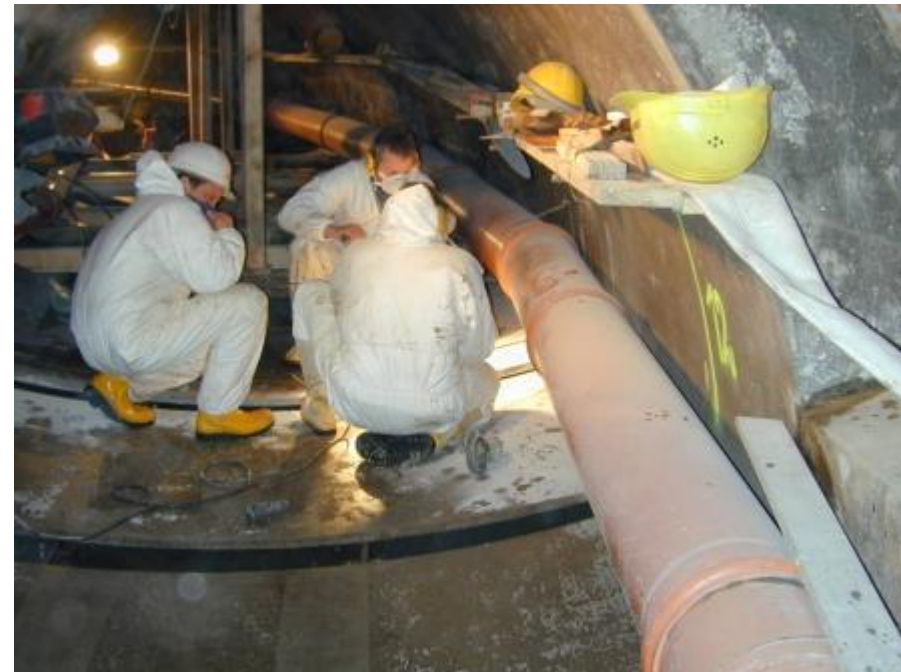
5.5b) ábra Burkolás Polyconcrete-ből készült elemekből
