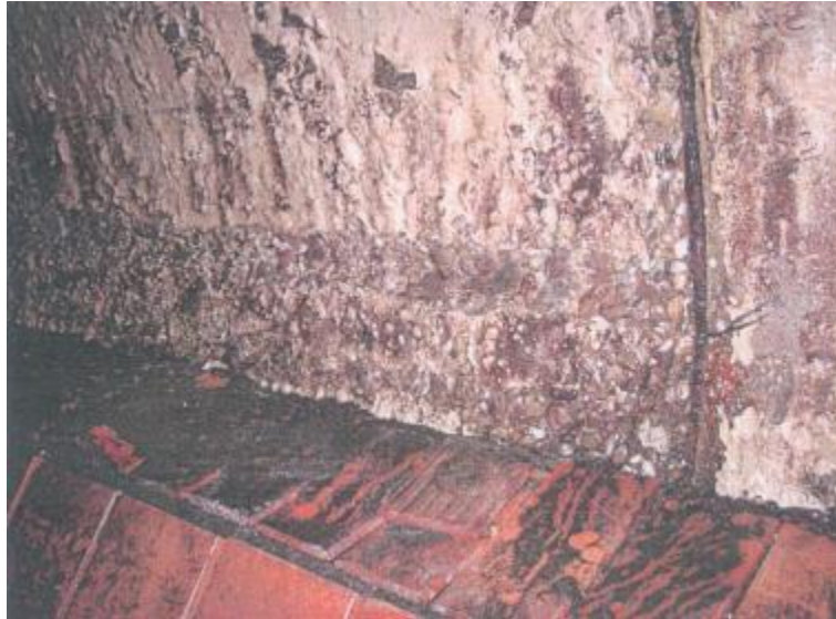
5.4a) ábra Szennyvízcsatorna burkolása DN 2500 öntartó PE lemezekkel és külső távtartókkal (Befogadócső állapot I)
