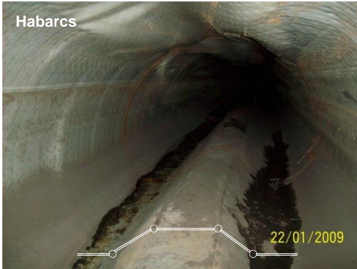
2.2 ábra Habarcsbevonat, négy törésvonal a folyásfenéken
