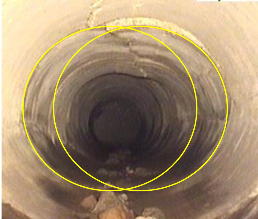
1.10 ábra Darabos törés
