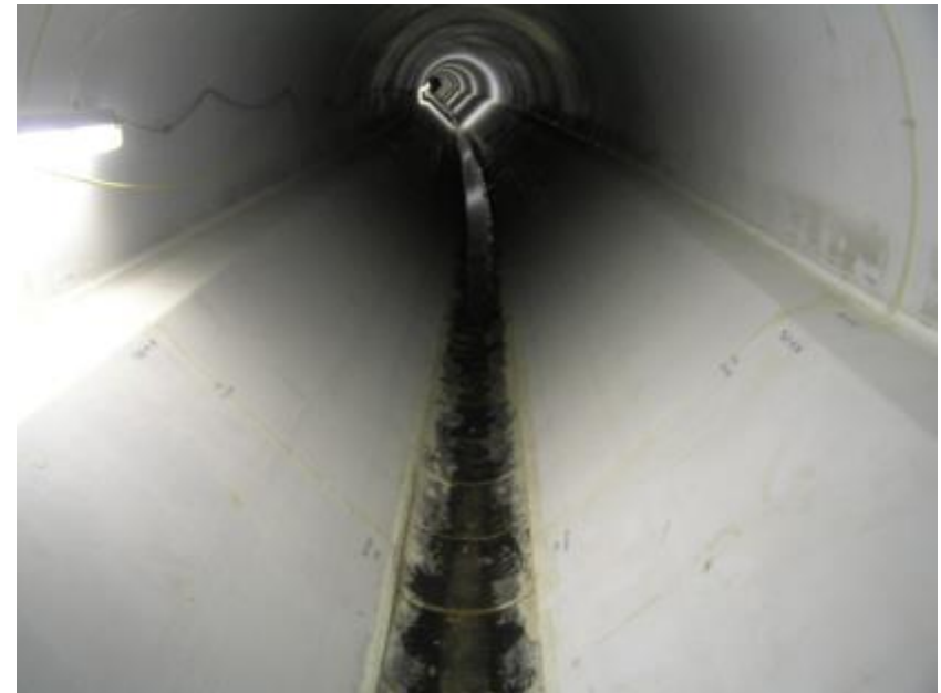
5.4c) ábra Elkészült burkolás
