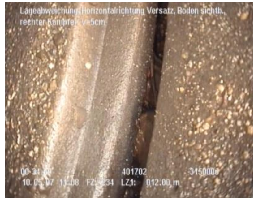
1.8 ábra Hosszirányú tokelmozdulás
