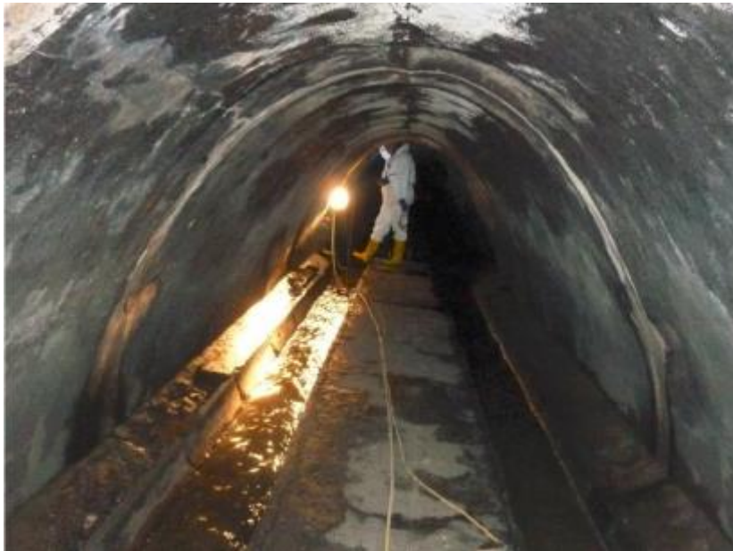
5.8a) ábra Parabolikus boltozat (2350:1970) repedés a csőtetőn
