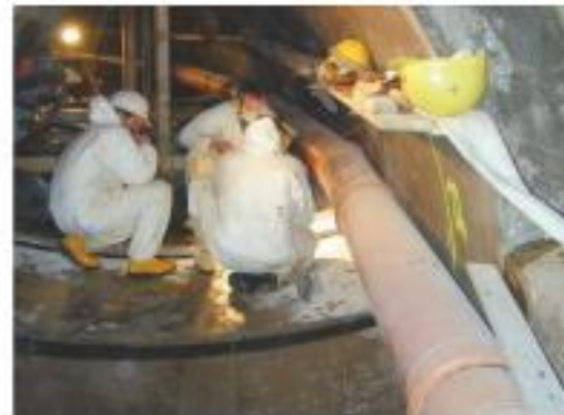
5.5b) ábra Bélelés polimerbeton elemekkel
