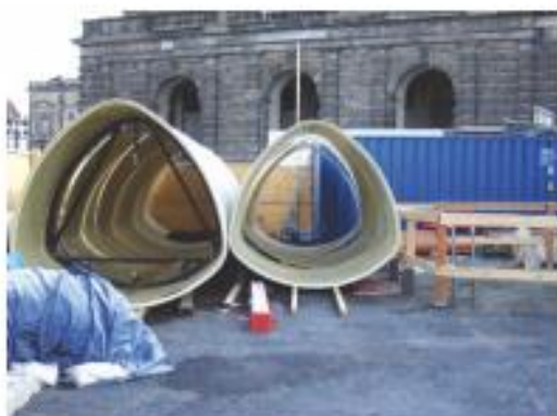
5.7a) ábra Szennyvíz fogyújtó csatorna bélelése Drezdában SZ:M = 2900:2780 mm
