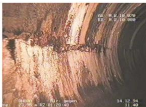
1.2 ábra: Hosszirányú repedés a vállvonalnál, a vállvonal zónája sérült
