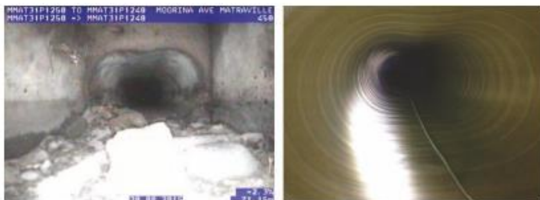
Fig. 5.2: Sajátos geometria („nyolcas alak”) SZ:M = 650:440 mm a helyreállítás a) előtt és b) után
