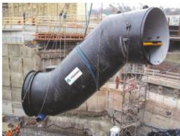
5.3a) ábra DN 3500-as vasút alatti szennyvízátvezetés (Photo: Frank GmbH)
