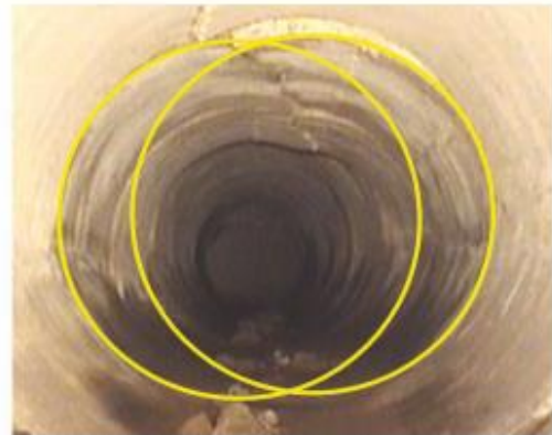
1.10 ábra: Belógó részek, ovalitás mérés DWA-A 143-2, B módszer szerint: \omega_{GR,v} = 10,7\% \rightarrow HPS III
