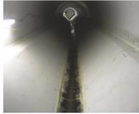
5.4c) ábra Elkészült bélelés
