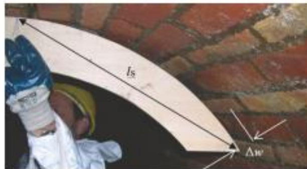
5.6b) ábra Hajlásszög \Psi mérése sablonnal (körtől való eltérés)
