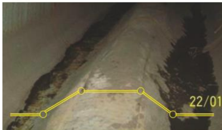
2.2 ábra: Habarcs burkolat, négy törésvonal a folyásfenéken
