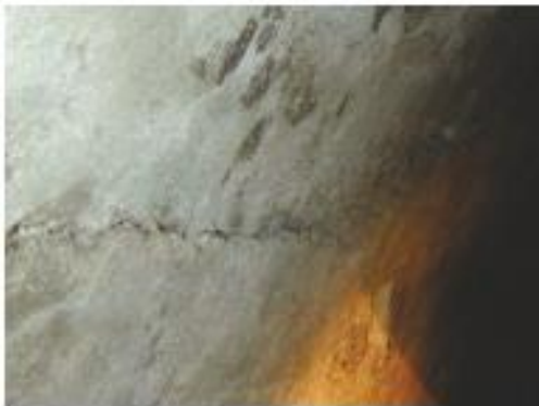
5.5a) ábra A beton gyűjtődeső sérülései M:SZ = 2050:2750 mm (HPS II vagy HPS III)
